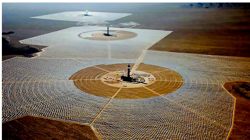
Одна из крупнейших солнечных электростанций в Австралии.
